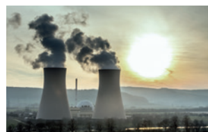
Градирни на электростанциях
