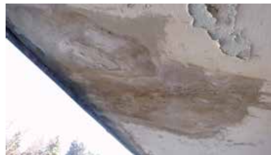
Недостаточная гидроизоляция балкона приводит к массивным повреждениям.
