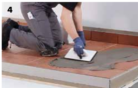
Затирка швов с ASO®-Flexfuge.
