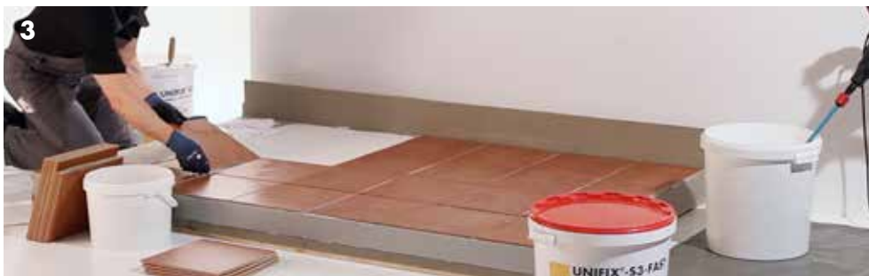
Укладка плитки в клеевую постель комбинированным способом с нанесением клея и на основание, и на плитку.
