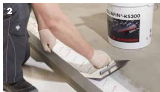
Укладка системной гидроизоляционной ленты ASO®-Dichtband-2000 при помощи AQUAFIN®-RS300 на балконный кромочный профиль.
