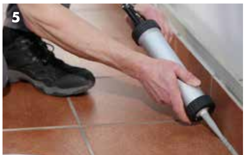
Герметизация деформативных швов при помощи ESCOSIL-2000.
